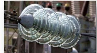
**НА ПОВЕРХНОСТИ ИЗОЛЯТОРОВ ЕСТЬ НАПРЯЖЕНИЕ.**
